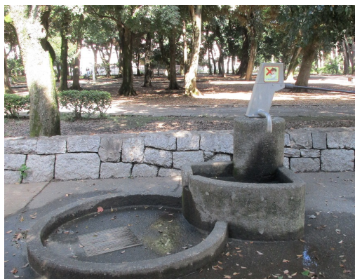
マンホールトイレ用井戸
