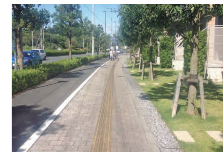
●排水溝に自然素材を用いることで、隣接した植栽帯に馴染ませる。
