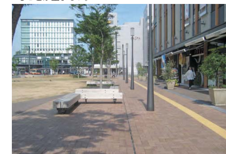
●境界部分の排水溝をできる限りスリムにし、目立たないように工夫する。
