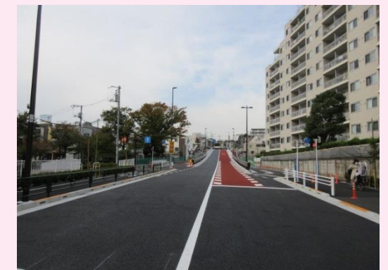
交通開放された補助26号線 (令和4年10月27日交通開放時撮影)
