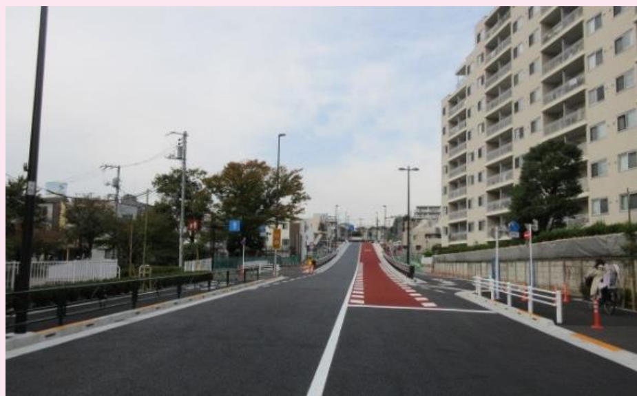
交通開放された補助26号線 令和4年10月、区内を縦断する補助26号線池尻・三宿区間が交通開放されました。地区の延焼遅延帯としての役割を果たすと同時に安全で円滑な交通の確保を今後担っていきます。
