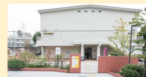
まもりやまテラス(H31完成)
