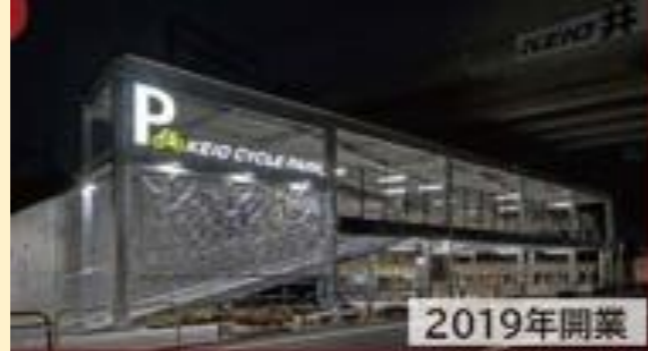
京王井の頭線高架下に整備された自転車等駐車場「京王サイクルパーク下北沢」(370台)
