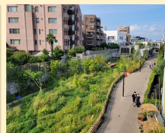
通路及び緑地・小広場(R3完成)
