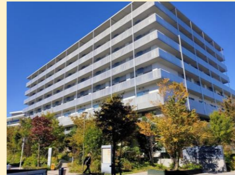
民間施設棟「東京リハビリテーションセンター世田谷」(H31完成)
