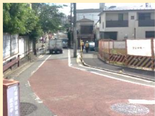
整備前の様子
