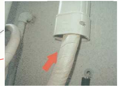
配管カバーの開口部
