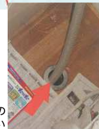
洗濯機の排水口が大きい
