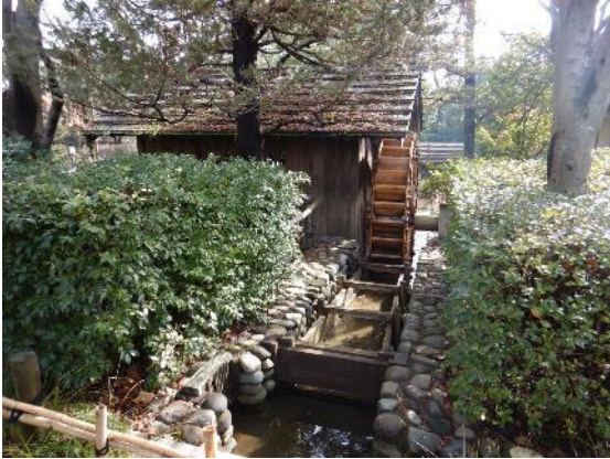
写真 4-23. 水車遠景 水路上流側
