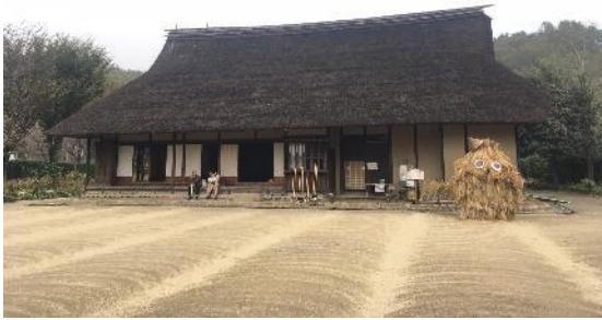
写真 4-15. 里山民家 全景
