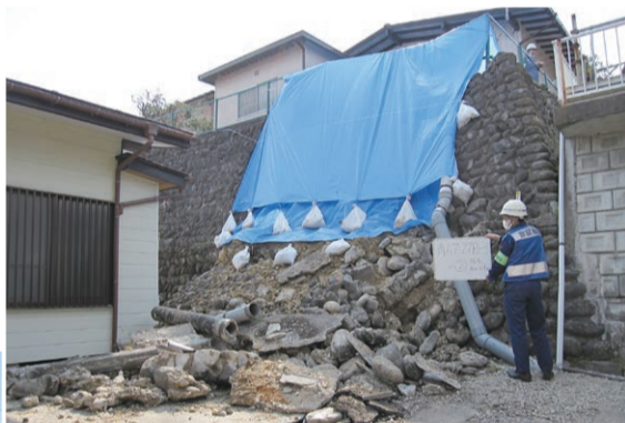
被災地宅危険度の判定業務 (宮城県仙台市)
