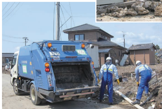
災害により発生した生活ごみ等の収集作業 (宮城県仙台市)
