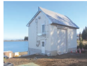
▲雑水山第二発電所外観(新潟県津南町)
