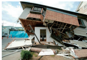
▲耐震シェルター
