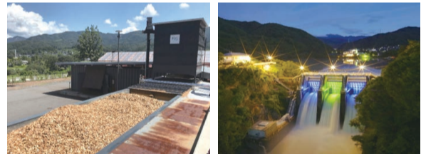
▲川場村(木質バイオマス発電) ▲長野県(水力発電)
