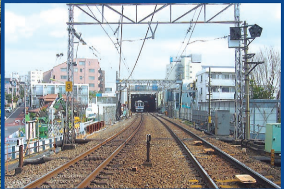
小田急線地下化前の様子
