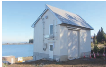
▲津南町(新潟県)…小水力発電
