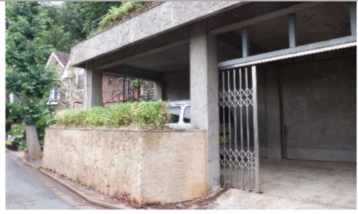
撤去する構造物
