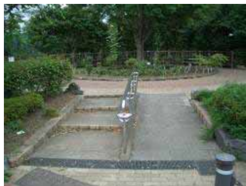
スロープの設置 (八幡山かまのくち緑地)
