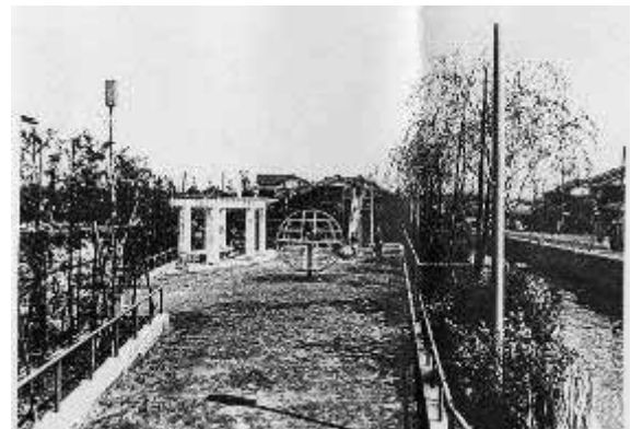
昭和 32 年 経堂大橋
