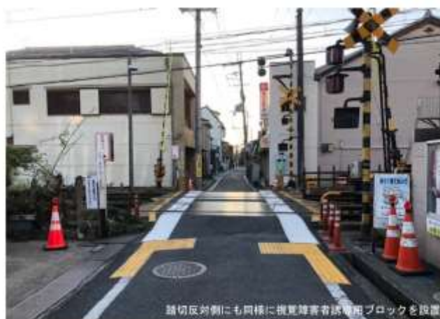
写真 2-7-8 踏切道手前部に視覚障害者誘導用ブロックを設置した事例
