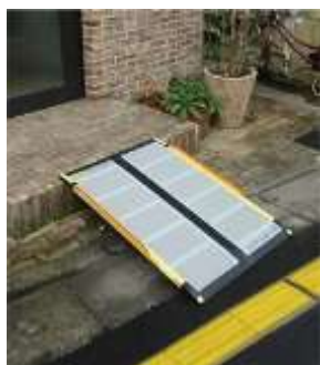
写真 4.5 一時的に使用するための 段差解消スロープの設置例
