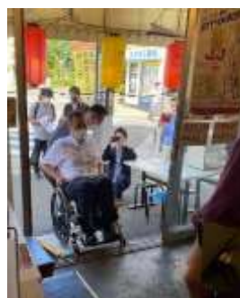
写真 4.6 店舗入り口に設置した 段差解消スロープを使用している様子
