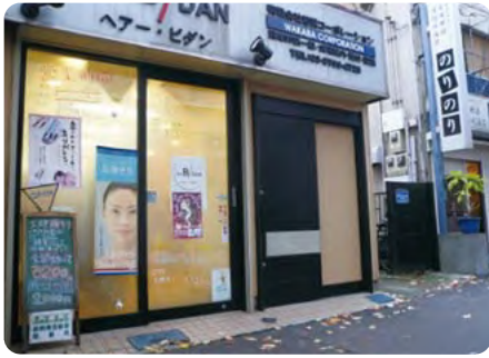
開き戸を自動ドアとし、入口の段差を無くした店舗
