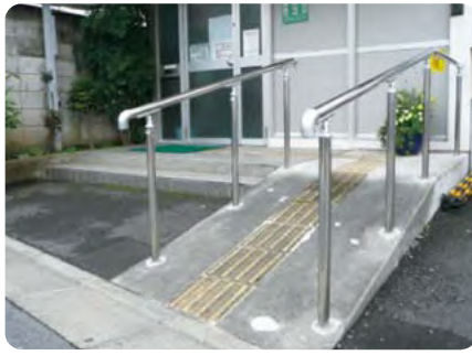
階段にスロープを併設した病院の玄関口
