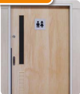
窓や指はさみ防止の スペースがある引き戸 (八幡山保育園)
