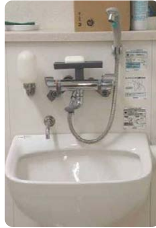
オストメイト対応設備に 温水とシャワーヘッドの ある設備
