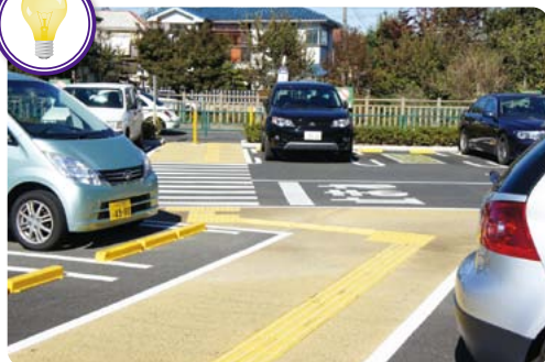
通路と車路が色分けされた駐車場
