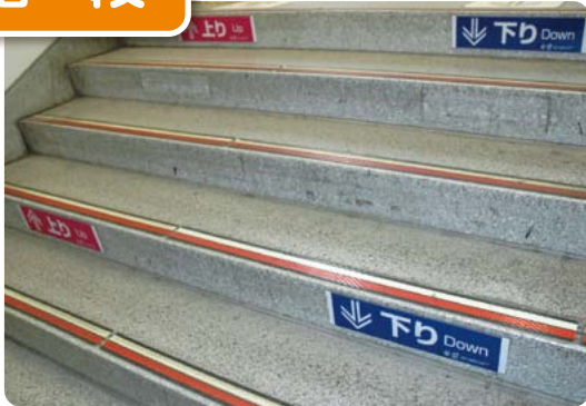
段の端部が目立つ色で示され、滑り止めのある階段
