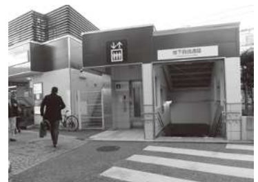
地下自由通路にエレベーターを整備した事例
