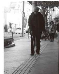
誘導用ブロックの敷設確認の様子
