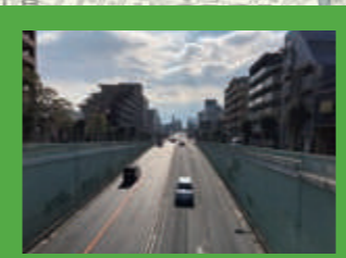
常盤陸橋から見える環状七号線は幹線道路の一つです。
