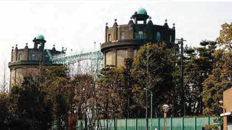
駒沢給水所の給水塔
