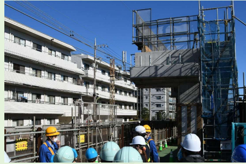
高架化工事状況
