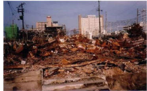
火災の延焼 (阪神・淡路大震災)
