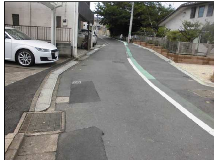
写真 区画道路 10 号 (幅員 6.0m)
