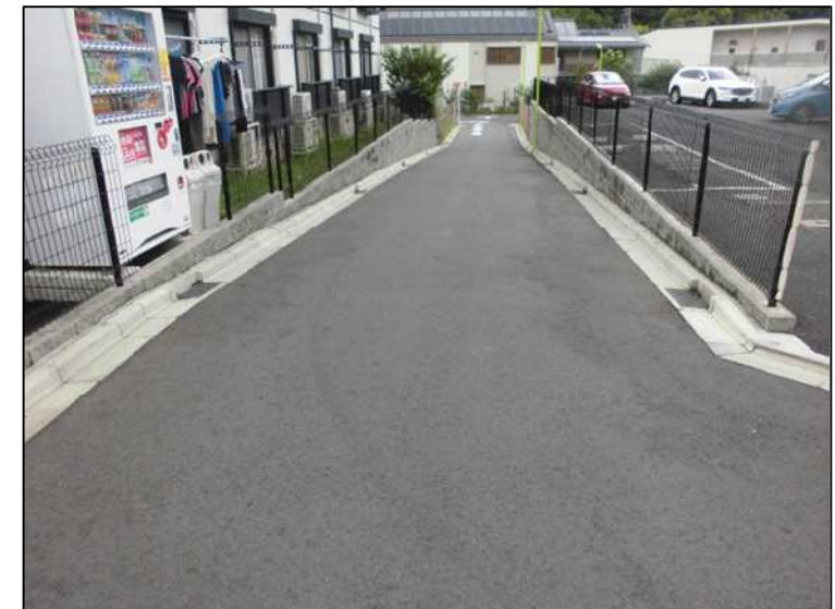
写真 区画道路 29 号 (幅員 4.0m)
