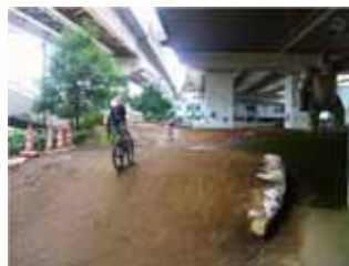
高架下を自転車コースの ある公園に整備した事例 【外環道（川口市）】
