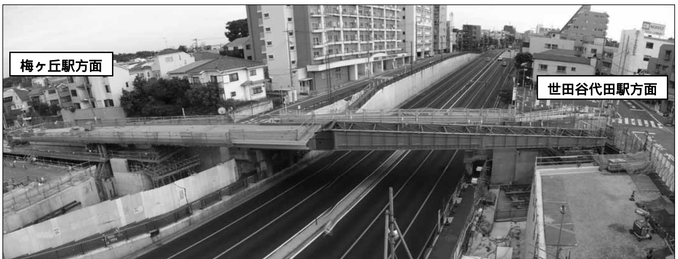
環状七号線横断橋の架設風景（環状七号線世田谷代田駅付近より撮影）
