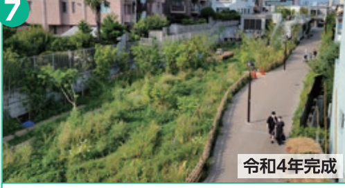
7 令和4年完成 通路及び緑地・小広場
