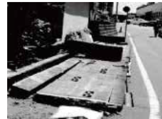
ブロック塀等の倒壊被害の例
