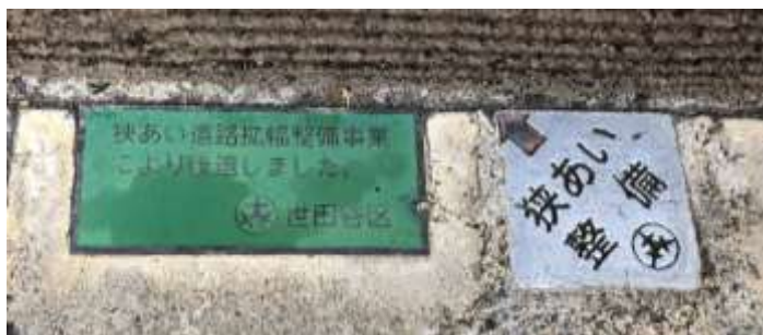
4m以上の幅を確保するため、セットバックした土地を道路として整備したことを示すプレート (狭あい道路拡幅整備事業)
