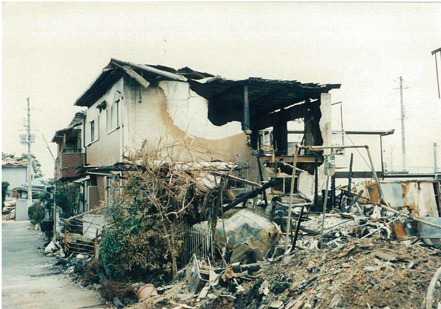
周辺への延焼を止めた鉄骨2階建て戸建て住宅(西宮市)
