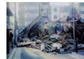
通行ができなくなった街路 (神戸市中央区)
