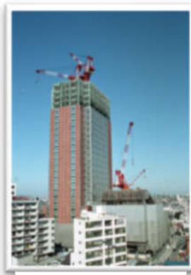
建設工事中のキャロットタワー 平成7年10月27日
