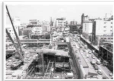
「三軒茶屋・太子堂四丁目地区市街地再開発事業」の工事現場 平成6年8月3日
