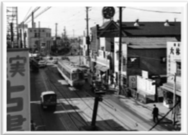
拡幅前の玉川通り 交差点の奥に世田谷通りがみえる 昭和34年1月
