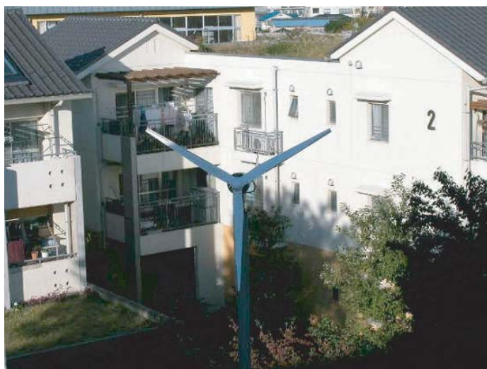
深沢環境共生住宅
