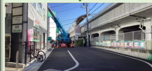
小田急線沿いの道路整備
