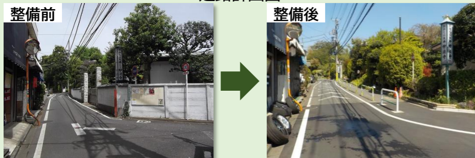
区画道路3号(一部)の整備
