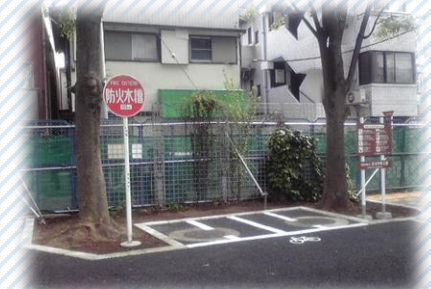
▲防火貯水槽（玉川中町公園）
