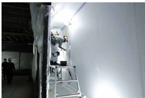
展示ケース改修作業
