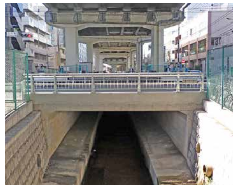
写真5 現在の田中橋 橋を境に手前が開渠、奥が暗渠となる。
