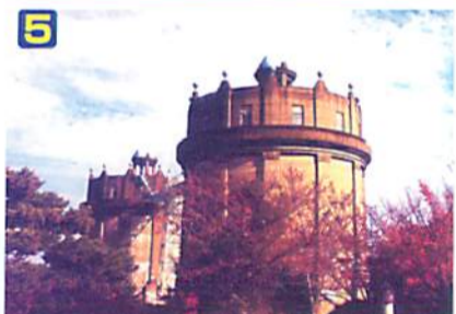
5 駒沢給水塔 水道が計画され、大正13年完成。頭に王冠をかぶったような一對の丸い大きな塔がそびえ立ちます。
