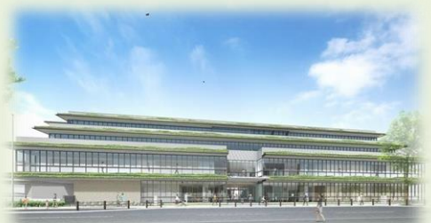
玉川総合支所(建設中)
