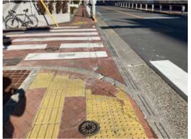
道路構造を見直し、歩道と車道との段差を少なくした例
