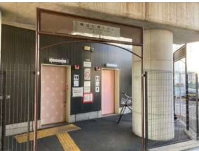
音声誘導装置が整備された公衆トイレ
