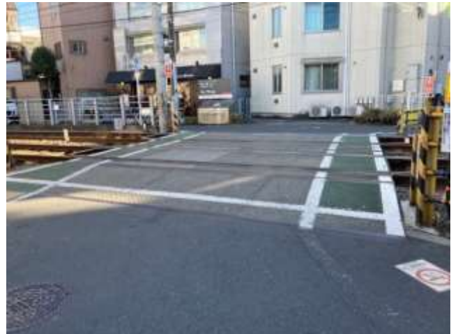
車椅子などが、レールの溝に脱輪しにくくなるよう、道路と線路の交差角度を直行させた踏切の例。
