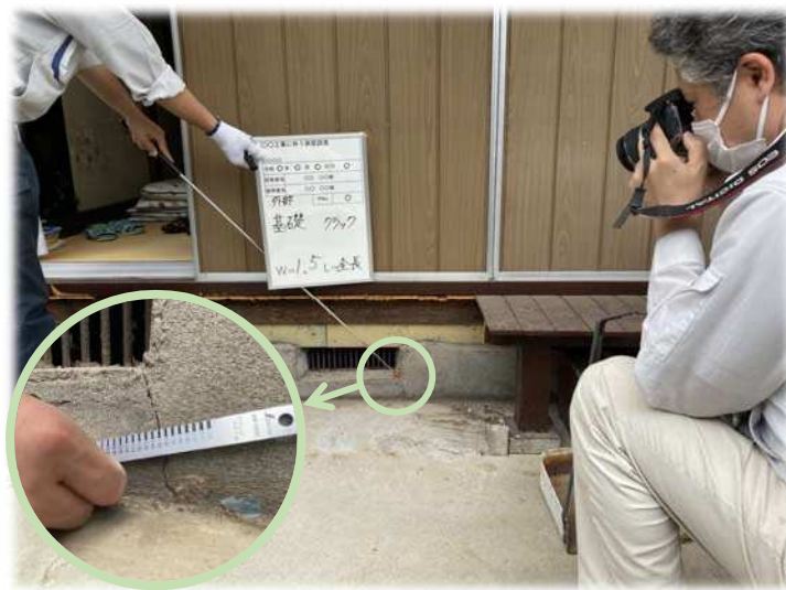
外壁・基礎調査
