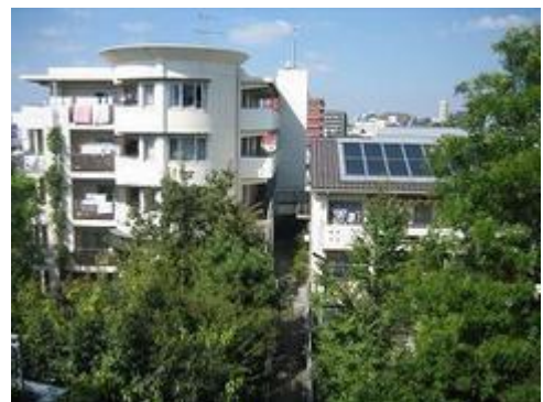
（世田谷区深沢環境共生住宅）
