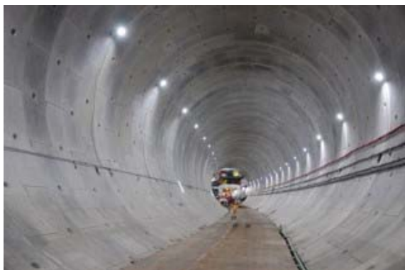
トンネル内部の写真(イメージ)
