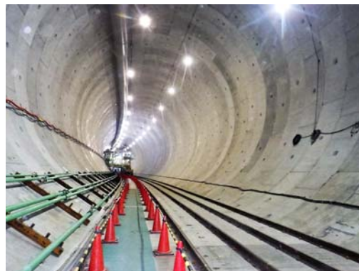
トンネル内部の写真(イメージ)
