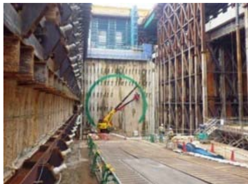
工事の写真(イメージ)
