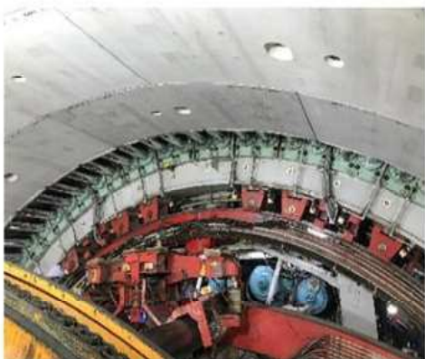
写真1 坑内状況写真(マシン上部)
