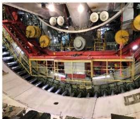
写真2 坑内状況写真(マシン下部)
