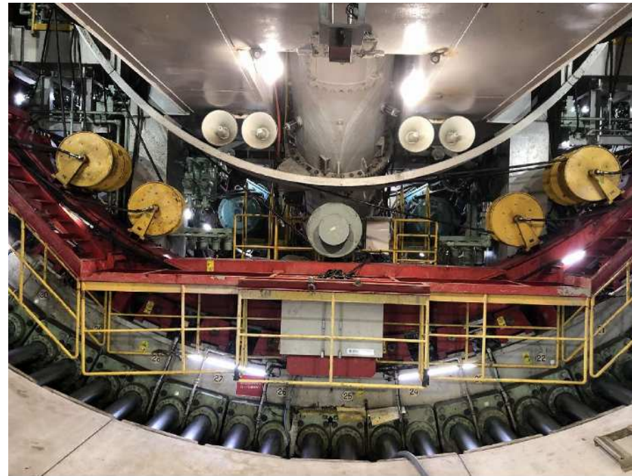
写真2 坑内状況写真(マシン下部)
