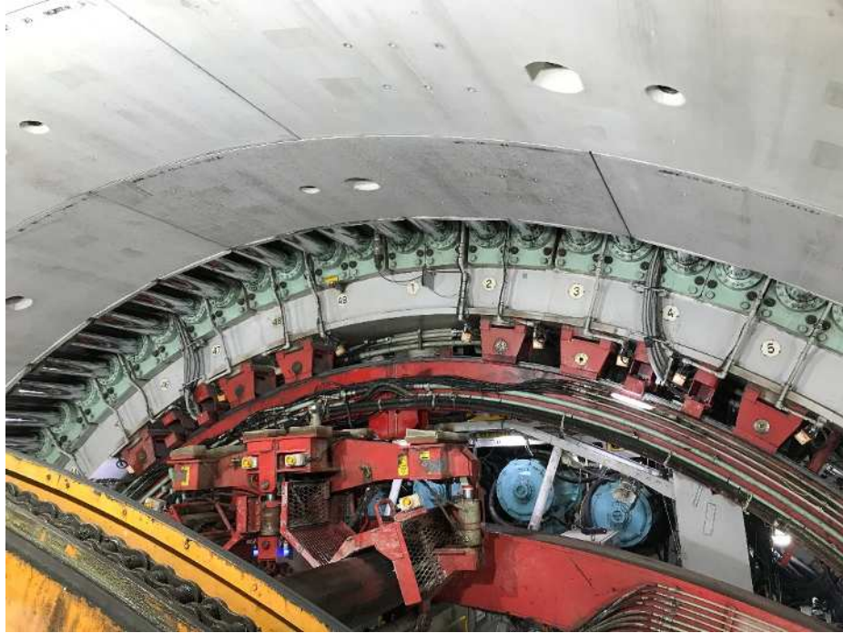
写真1 坑内状況写真(マシン上部)
