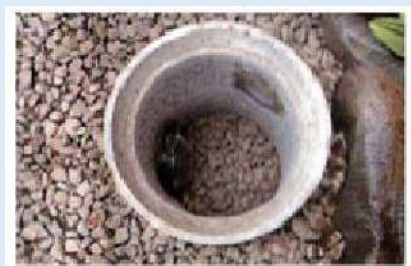
図：雨水浸透ます
