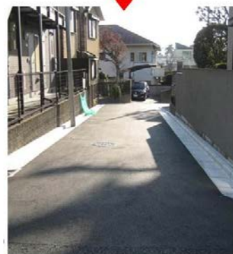
狭あい道路拡幅 (出典：世田谷区 HP)
