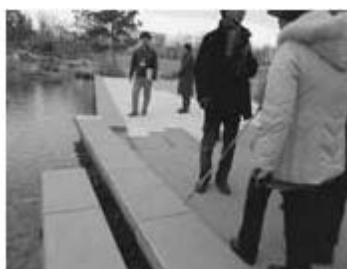
竣工後の池の端の確認
