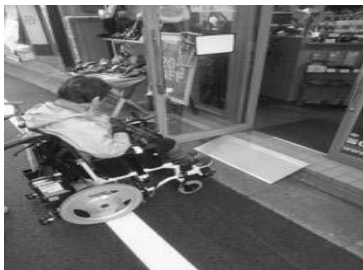
店舗への取り外し可能な 簡易スロープの設置
