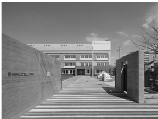
改築した小学校の様子
