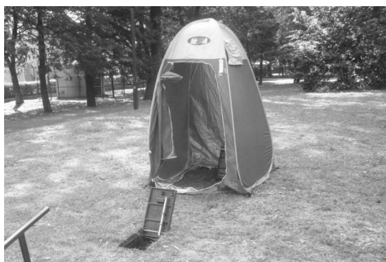
公園内のマンホールトイレ
