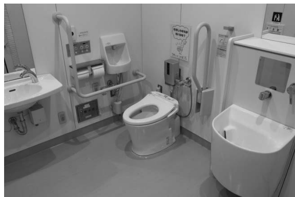
小学校内の多機能トイレの様子
