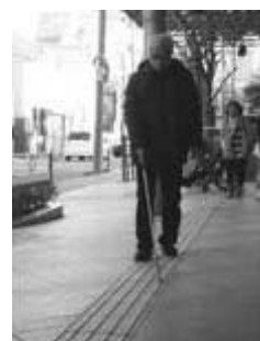
誘導用ブロックの 敷設確認の様子
